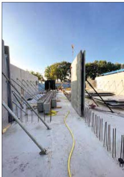
FIGURA 6 INSTALAÇÃO DE PEÇAS PRÉ-FABRICADAS FONTE: BFT - INTERNATIONAL (2023)
