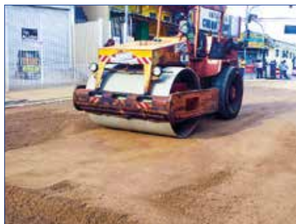
TRECHO 1 – BG R TC R – Brita graduada reciclada tratada com cimento reciclado
