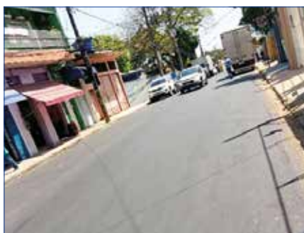
Pavimento asfaltado finalizando a execução
